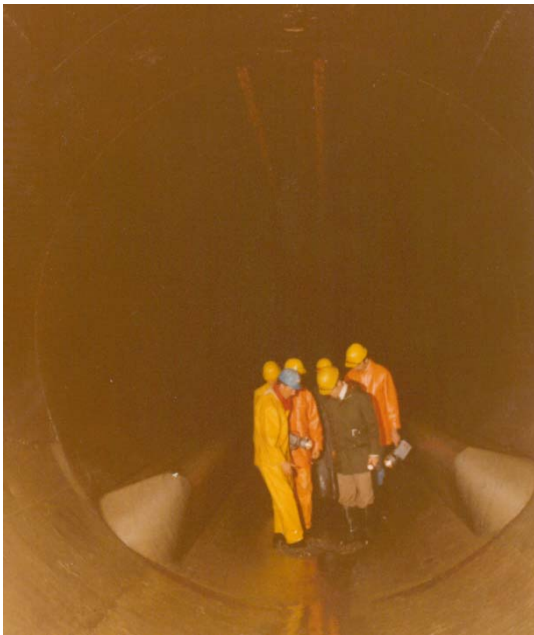
Abb. 4.3.26 Beruhigungsschwellen, UK KW Kaunertal, [e]
