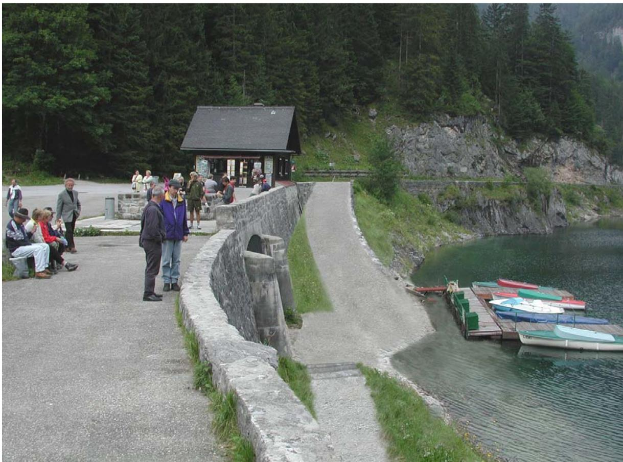
Abbildung 12: Bootsanlegestelle mit Einlaufbauwerk der umgebauten Hochwasserentlastung über den Schrägschacht (Fotomontage, vgl. Abbildung 5)
