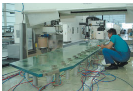
Bild 10. Nachbearbeitung der Wangen mit laminierten Beschlagelementen (Foto: Seele)
