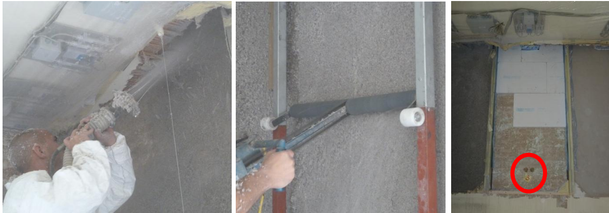
Abb. 14 Feld 1, Balken 1 & 2: Aufspritzen der bindemittelverstärkten Zellulosedämmung
