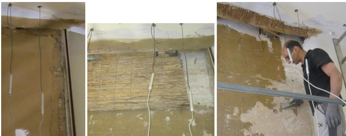
Abb. 30 Links zeigt den verputzten Zustand. Anschließend wurde der Lehmputz von der Schilfdämmung geklopft und mit dem Armierungsgewebe vollständig abgezogen. In weiterer Folge Auslösen der Schilfplatten und Abscheren des Lehmklebers vom Untergrund.
