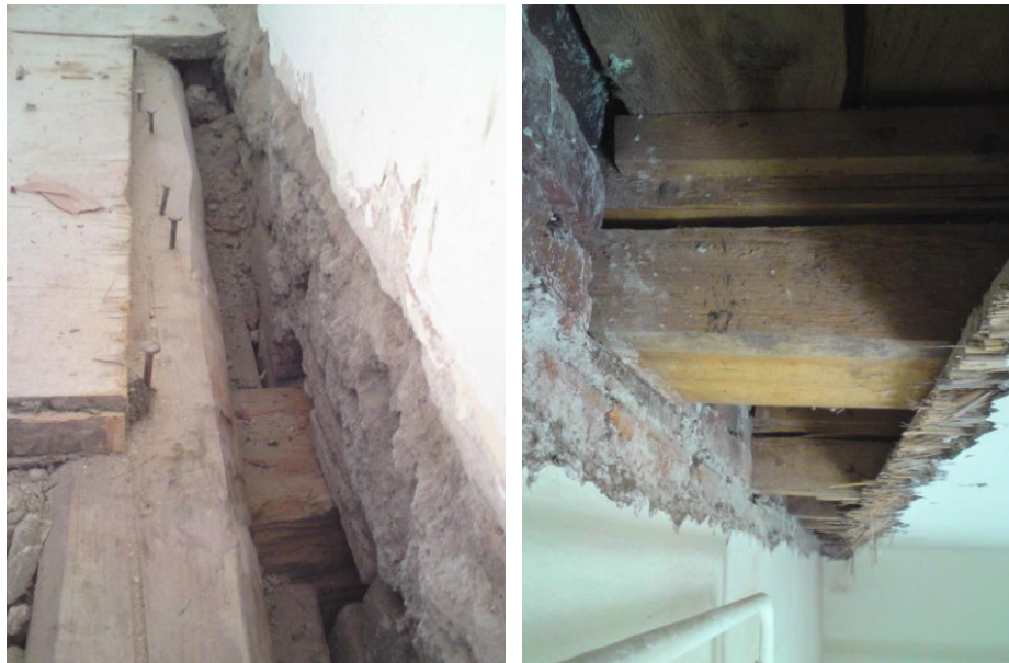
Abb. 4 Links Deckenöffnung im Dachgeschosszimmer (DG) und rechts im Zimmer des Obergeschosses (OG)
