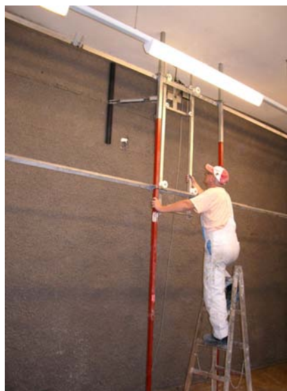
Fig. 13 Gesamtansicht des Prototyps des neuartigen Abziehsystems
