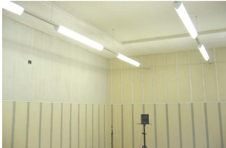
Fig. 54 Blick in die Klasse nach der Sanierung
