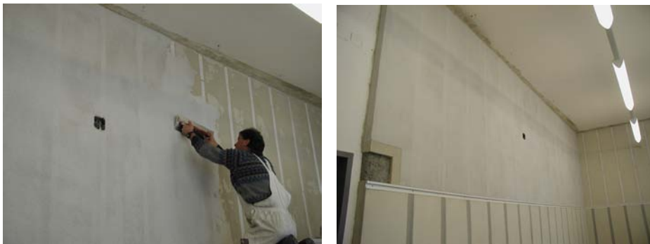
Fig. 25 Applikation des Einkornputzes auf Probe VI_mB
