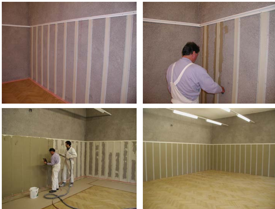
Fig. 23 Vor Ort Montage der Probe VII – Anheften, Fixieren und Verputzen der abgeklebten Aluminium-Lochblechprofile
