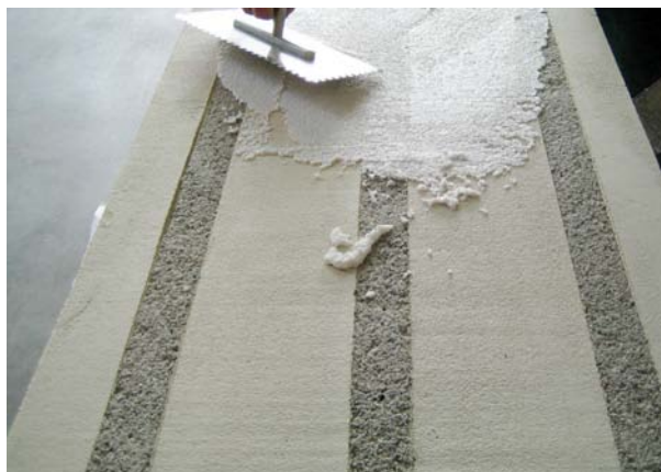
Fig. 22 Probekörperherstellung für die Hallraummessungen
