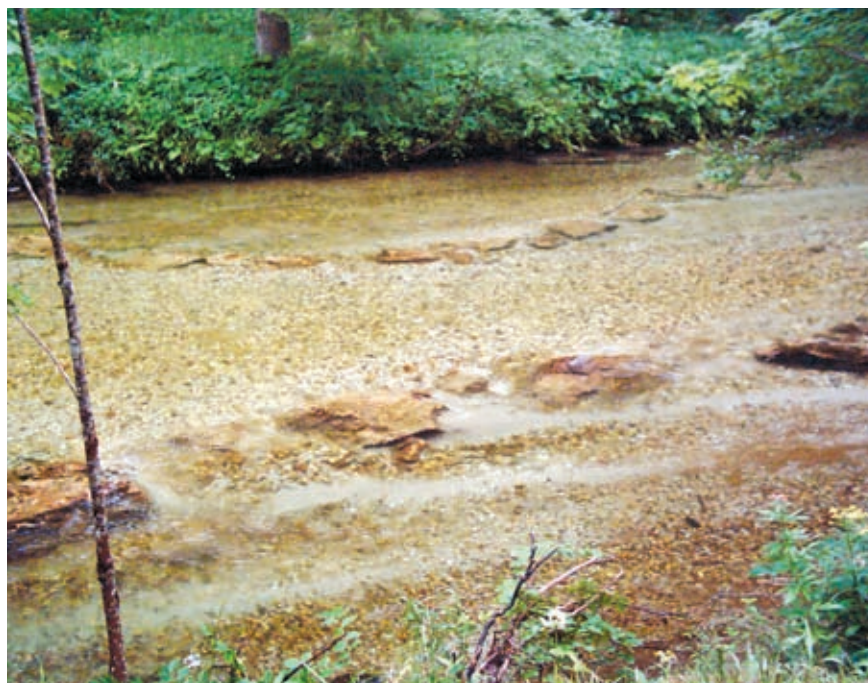
Bild 3: Deklinanter Strömungstrichter aus Lenkbuhnen in der Salza, Steiermark, mit ausgeprägter Substratsortierung (Foto: Glüh, 2005)
