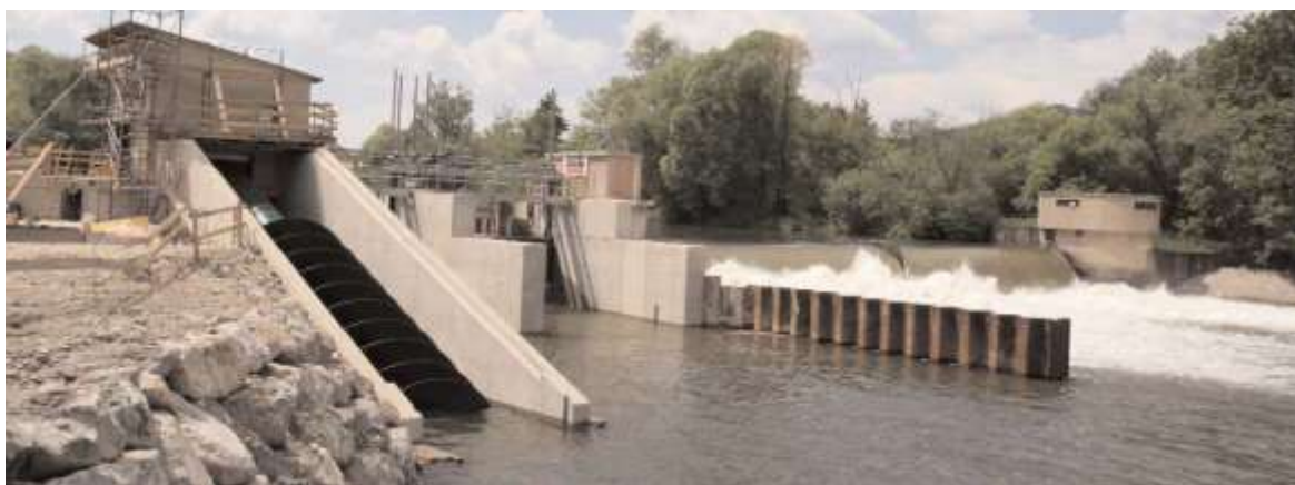
Figure 35: View of the power plant at Niklasdorf ( zek - Zukunftsenergie und Kommunaltechnik June 2008 )
