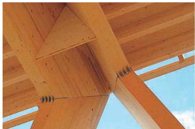
Abbildung 2: Rahmenecke des Erhaltungs- und Innovationszentrum in Frutigen (Schweiz) mit Eschenholzverstärkung
