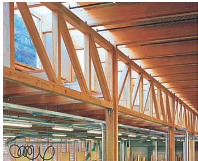
Abbildung 1: Fertigungshalle der Schreinerei Schnidrig in Visp (Schweiz) mit einer Tragstruktur aus Eschen-BSH
